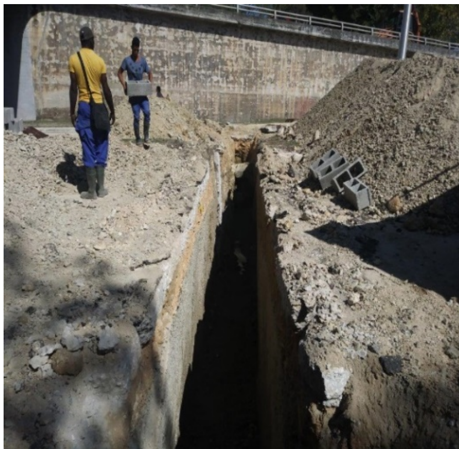
Figura 4.5. Limpieza de tragantes (elaboración propia).
