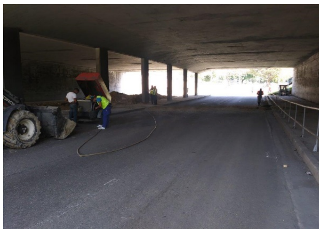
Figura 4.3. Mantenimiento correctivo de las redes de drenaje pluvial (elaboración propia).
