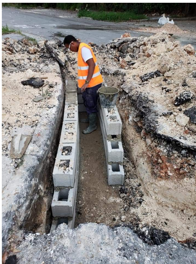
Figura 4.1. Construcción de una batería con 14 tragantes (elaboración propia).
