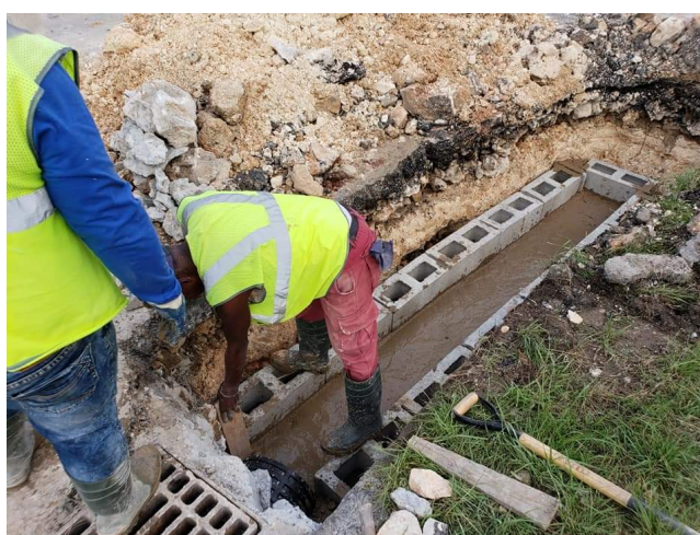
Figura 4.2. Construcción de una batería de siete tragantes (elaboración propia).
