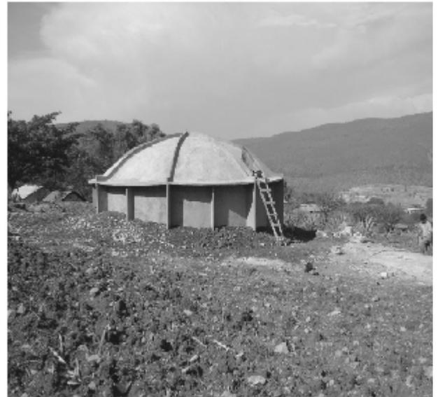
Figura 4. Tanque de almacenamiento de ferrocemento con capacidad de 123 m3
