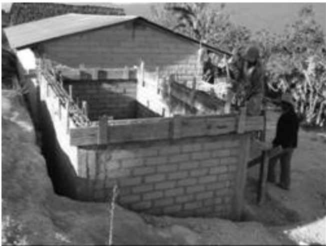
Figura 4. Detalle del colado de la cadena de cerramiento.
