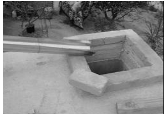
Figura 6. Detalles del acceso a las cisternas.
