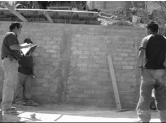
Figura 8. Detalles del proceso constructivo de las cisternas por los usuarios.
