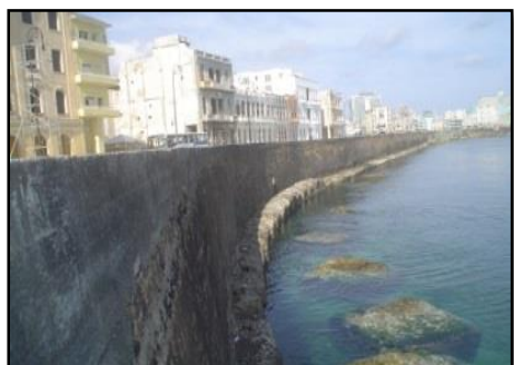
Figura 3. Foto de la sección transversal del muro actual
