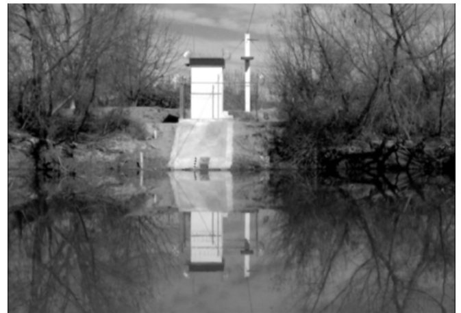
Figura 15. Caseta de la estación de aforo "Agustín Melgar"
