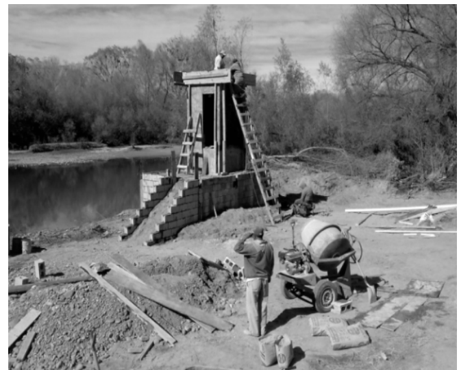
Figura 22. Construcción de la caseta de la estación de aforo "Paso Nacional".
