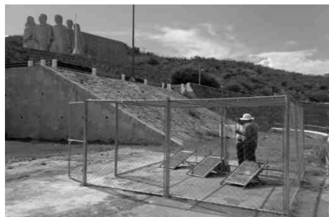
Figura 11. Fotoceldas y transmisor satelital de la presa "Lázaro Cárdenas"
