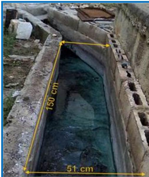
**Figura 3. Canal donde se realizaron las mediciones para el cálculo del caudal en 2015**
