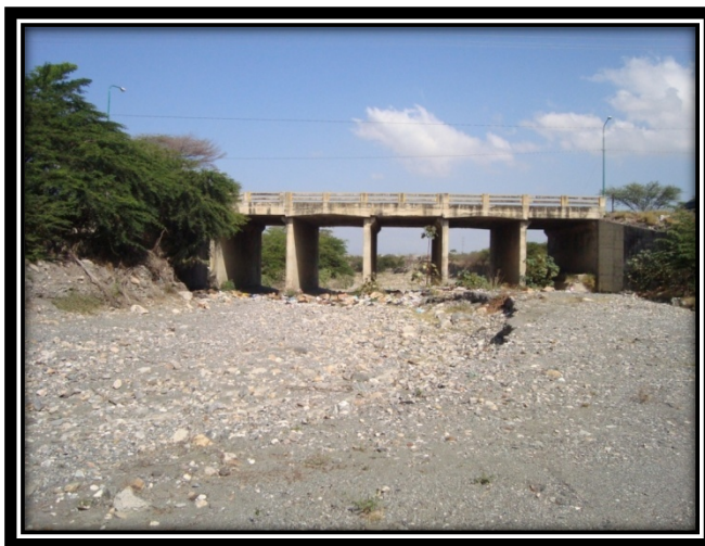
Figura 1. Puente sobre la quebrada Atarigua (fuente propia)
