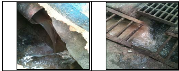
Figura 3. Canal de vertimiento de aguas residuales de la planta de procesos varios
