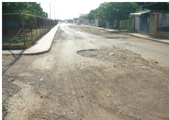
Figura 1.- Vista de la zona de estudio.
