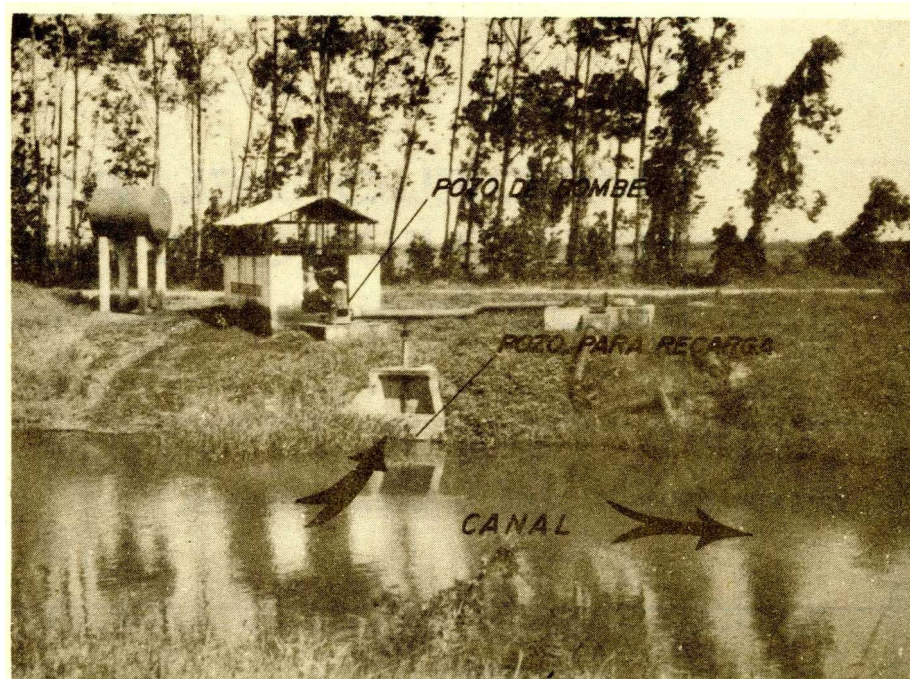
Figura 3. Vista de un tramo del canal Herradura- Los Palacios con la ubicación de los pozos de explotación y recarga (tomado de González Báez 1973)
